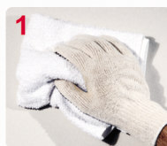
1 LIMPE A SUPERFÍCIE A SER PINTADA
